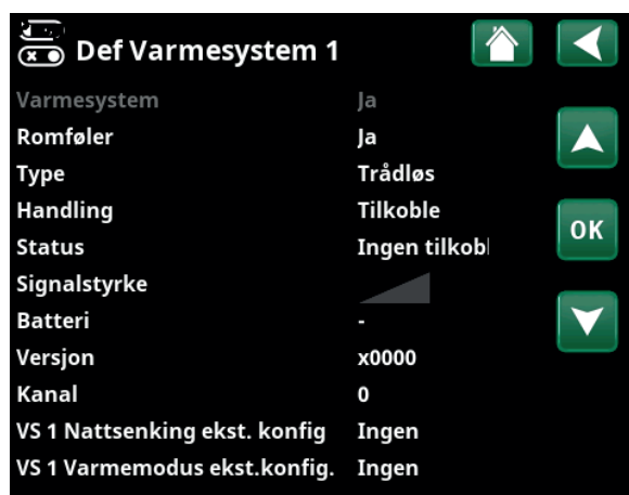
Meny «Avansert/Definere/Varmesystem/Varmesystem 1». Trådløs romføler er valgt.
