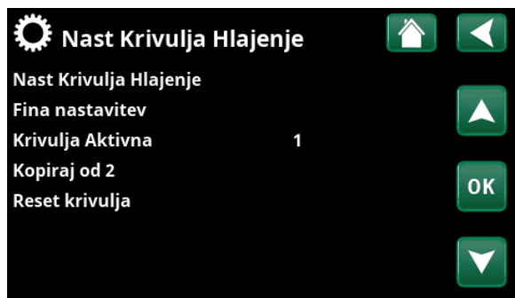
Meni: »Instalater/Nastavitve/Hlajenje/Krivulja Hlajenje/Nast. Krivulja Hlajenje«.
