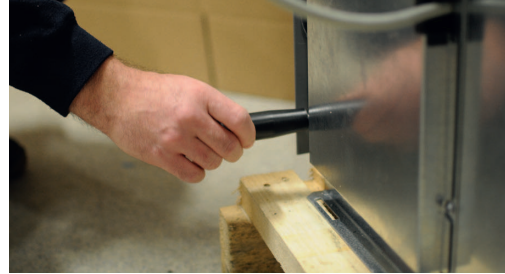
2. Fest de to bærehåndtakene i kjølemodulens nerkant.
