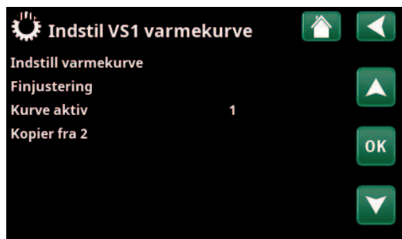
Menu "Avanceret/Indstillinger/Varmesystem/Varmesystem 1/ Varmekurve".
