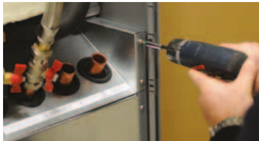
3. Skruva bort kylmodulens fästsruvar.
