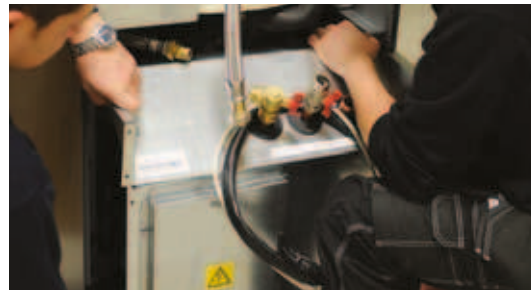
4. Dra ut kylmodulen genom att först lyfta framkanten lite uppåt i bärhandtagen.
