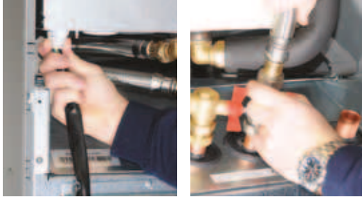
1. Lossa kylmodulens elkabelkontakt och slangar.
