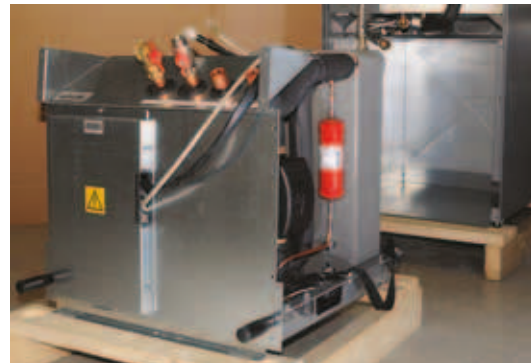
6. Lyft in kylmodulen i produkten med hjälp av bärhandtag och bärremmar. Lossa bärhandtag, samt återmontera elkabelkontakt, slangar och skruvar.
