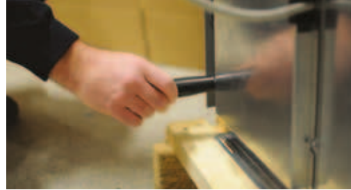
2. Fäst de två bärhandtagen i kylmodulens nederkant
