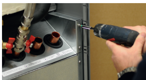
3. Avlägsna kylmodulens fästskruvar.
