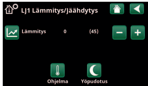
Valikko "Edistyneellinen/Määrittele/Lämmityspiiri/Lämmityspiiri 1". Lämmityspiirissä ei ole huoneantureita, asetusarvo suluissa (menoveden lämpötila 45 °C). Asetusarvon vasemmalla puolella näkyy ulkolämpötila (0 °C) nykyisellä menoveden lämpötilalla.
