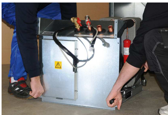
5. Lyft kylmodulen med hjälp av bärhandtag och bärremmar.
