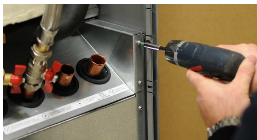
3. Skruva bort kylmodulens fästsruvar.
