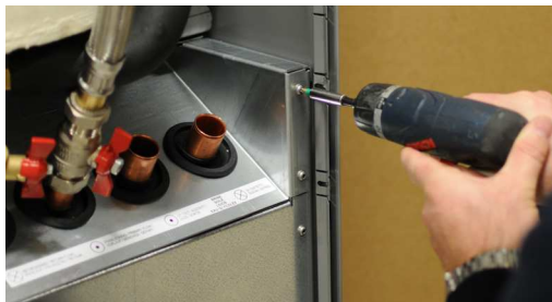
3. Skru kølemodulets skruer af.
