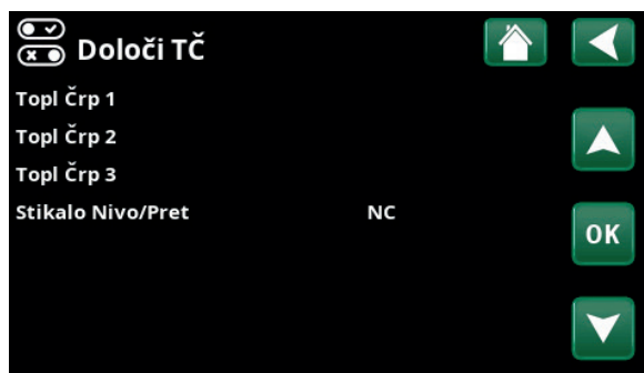
Primer sistema s 3 toplotnimi črpalkami.
