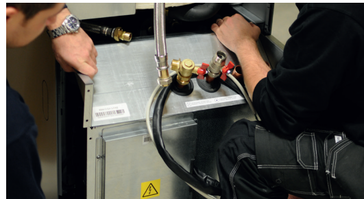
4. Vedä kylmämoduuli ulos ja nosta samalla hieman ylöspäin kahvoista.
