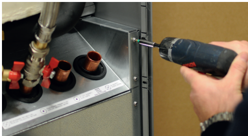
3. Poista kylmämoduulin kiinnitysruuvit.
