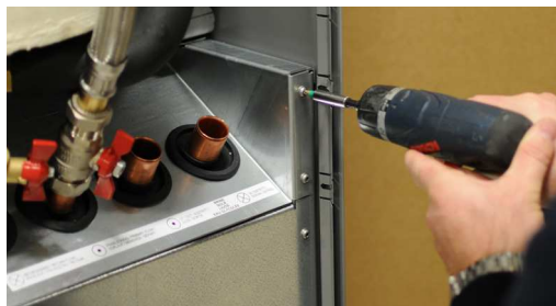
3. Poista kylmämoduulin kiinnitysruuvit.
