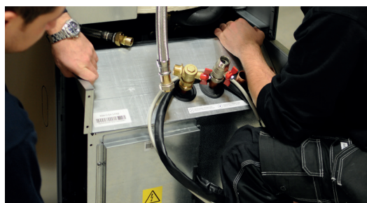
5. Træk kølemodulet ud ved først at løfte forkanten lidt op ved hjælp af bærehåndtagene.
