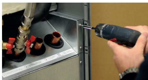
3. Skru kølemodulets skruer af.
